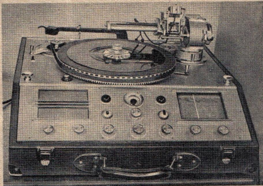
Ein Schneidgerät in Kofferform für Folien, in das ein Opta-Zwergsuper eingebaut ist. Der Motor ist für  $33\frac{1}{3}$  und 78 Umdrehungen eingerichtet. Rechts das Magnetbandgerät „Münchberg Ia“
