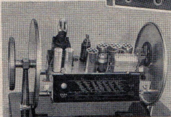
lich und trennscharf. — Ein weiterer Spezialempfänger ist der Presse-Hell-Empfänger für Zeitungsredaktionen, ausschließlich für Al-Hell-Betrieb (s. Abb. S. 325) gebaut und mit 2x UCH 11, 1x UBF 11, UCL II und UY 11 bestückt. Die Bandbreite beträgt entsprechend dem Verwendungszweck nur  $\pm 300$  Hz.
